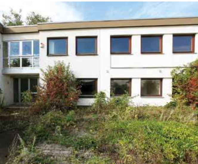
Arbeits-, Wohn- und Verwaltungsräume genutzt, sondern es entsteht
